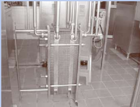
ภาพที่ 61 : แผ่นแลกเปลี่ยนความร้อน Plate Heat Exchanger (PHE)
