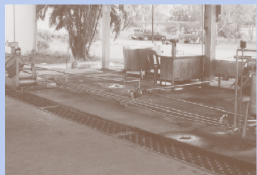
ภาพที่ 5 : ทางระบายน้ำนอกอาคาร
