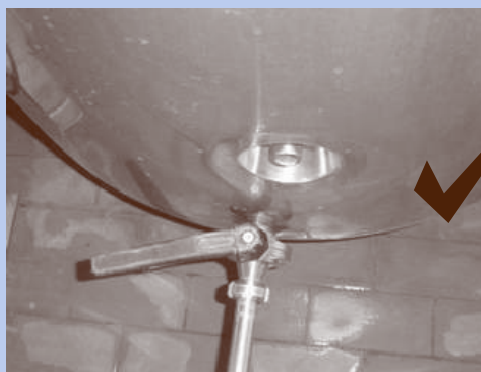
ภาพที่ 48 : การติดตั้งวาล์วใกล้กับตัวถัง
