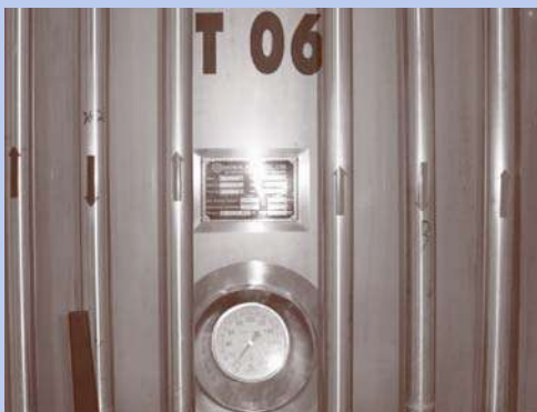
ภาพที่ 36 : สัญลักษณ์แสดงประเภทของท่อและแสดงทิศทางการไหล
