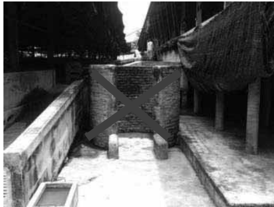
รูปที่ 6.6-1 สถานที่กำจัดซากสุกรที่ไม่ถูกต้อง
