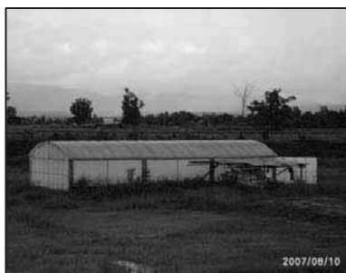
รูปที่ 8.3-2 โรงเก็บมูลสุกรตากแห้ง (ปุ๋ยคอก) แบบโครงสร้างพลาสติก
