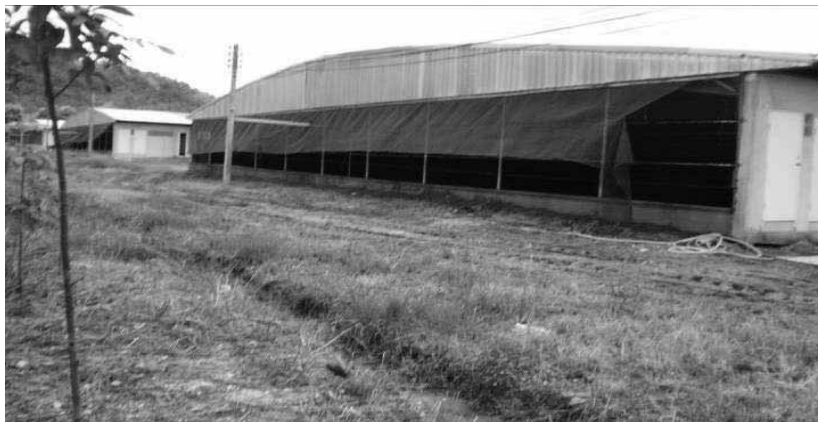
รูปที่ 7.3-15 ภาพถ่ายลักษณะภายนอกโครงสร้างปิดคลุมส่วนท้ายโรงเรือน
