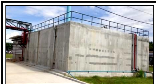
บ่อเก็บน้ำดิบ
