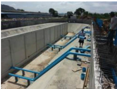
ภาพที่ 38 ระบบดาดฟ้าตะกอนของบ่อน้ำบาดน้ำเสีย
