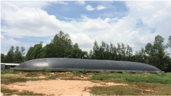
ภาพที่ 19 - 20 บ่อน้ำบำบัดน้ำเสียชนิดใต้ก๊าซชีวภาพแบบบ่อหมักราง (Channel Digester)
