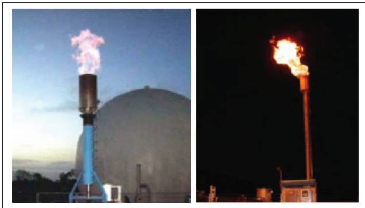
ภาพที่ 41 ชุดเผาก๊าซชีวภาพส่วนเกิน (Biogas Flare)
