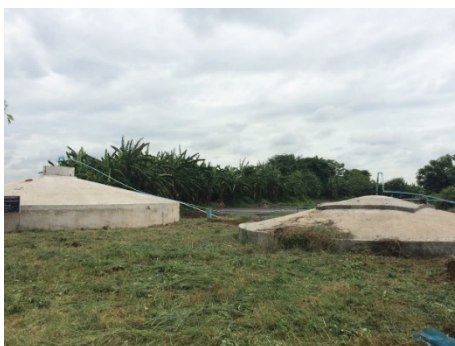
ภาพที่ 15 บ่อบำบัดน้ำเสียชนิดได้ก๊าซชีวภาพแบบบ่อโดมคงที่ (Fixed Dome)
