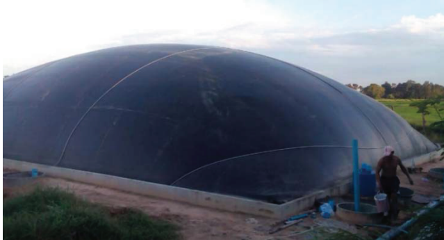
ภาพที่ 18 บ่อน้ำบำบัดน้ำเสียชนิดได้ก๊าซชีวภาพแบบบ่อโคเวอร์ลากูนประยุกต์ (Modified Covered Lagoon)
