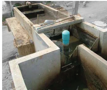
ภาพที่ 13 ตะแกรงดักขยะ ดักกรวดทรายและการตกตะกอน
