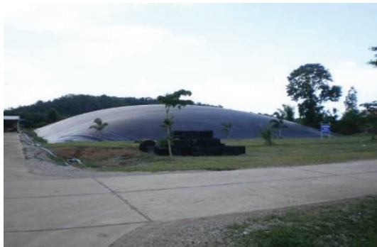
ภาพที่ 17 บ่อนำบำบัดน้ำเสียชนิดได้ก๊าซชีวภาพแบบบ่อคลุม (Covered Lagoon)
