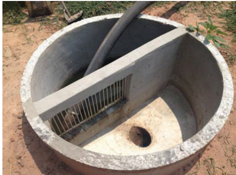
ภาพที่ 36 - 37 บ่อดักทรายและบ่อเติม
