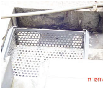
ภาพที่ 13 ตะแกรงดักขยะ ดักกรวดทรายและการตกตะกอน
