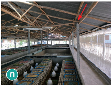
ภาพที่ 10 ตัวอย่างโรงเรือนเลี้ยงจิ้งหรีดที่ทำโครงหลังคาแข็งแรง
